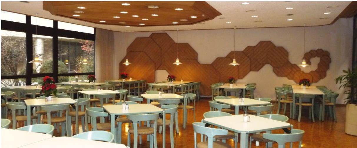
Abbildung 5: Kantine der BGN 2009; Geprägt von Holzelementen. Der alte Akustikputz wurde überstrichen und ist nicht mehr wirksam
