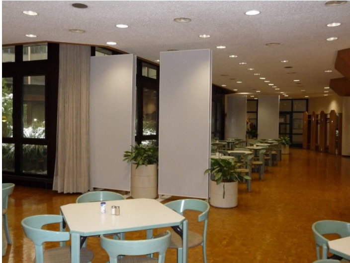
Abbildung 14: Blick auf den Kaffeebereich. Dieser wird vorne und hinten mit Schallabsorbern abgeschirmt
