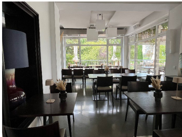
Abbildung 51: Von der Decke abgehängte Faserplatten im Gastraum; Quelle Bootshaus Mannheim; Foto: Lamprecht
