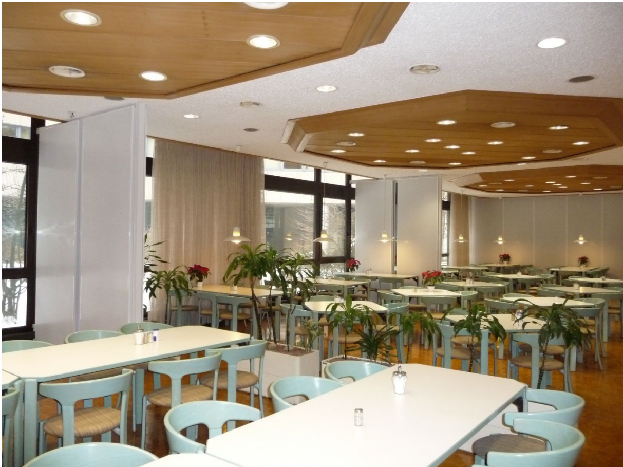
Abbildung 10: Kantine der BGN mit Nischen durch Schallabsorber sowie Schallabsorber an der Rückwand des Raumes
