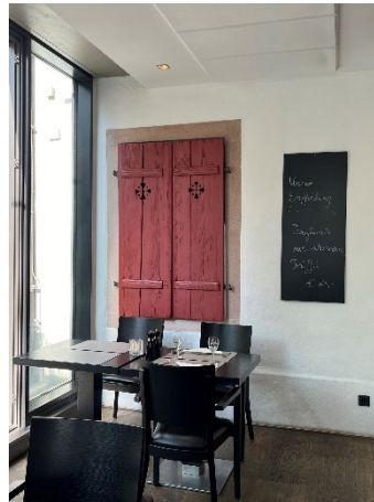
Abbildung 4: Gastraum im Erdgeschoss mit Akustikschaumplatten an der Decke; Quelle: Cantinaccia Heidelberg; Foto: Lamprecht
